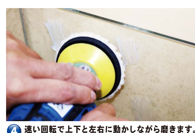
④ 速い回転で上下と左右に動かしながら磨きます。焼きつきをおこさないよう注意してください。水拭きをして研磨剤を拭き取り、仕上げてください。
