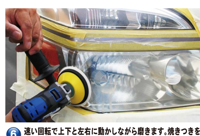
⑥ 速い回転で上下と左右に動かしながら磨きます。焼きつきをおこさないよう注意してください。水拭きをして研磨剤を拭き取り、ヘッドライトコーティング材を塗り仕上げてください。
