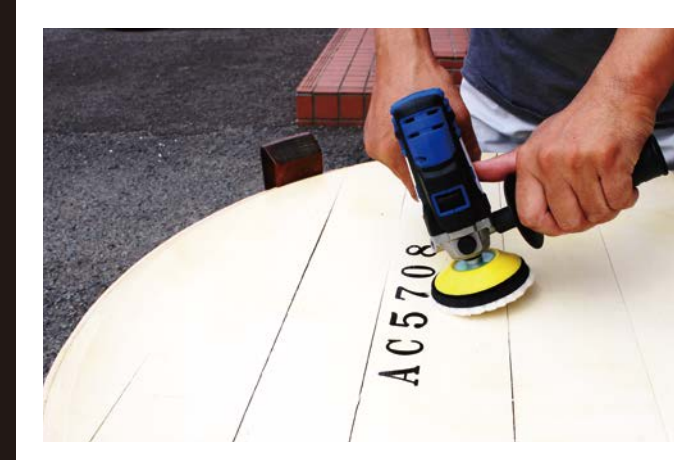
⑥ ウールバフで研磨する場合は、写真のように右側に傾けるように圧をかけ縦向きと横向きに研磨します。
