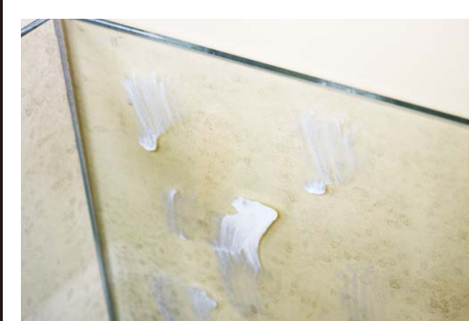
③ コンパウンドなどの研磨剤を塗ります。 ※ウールバフに直接研磨剤をつけると目詰まりします。
